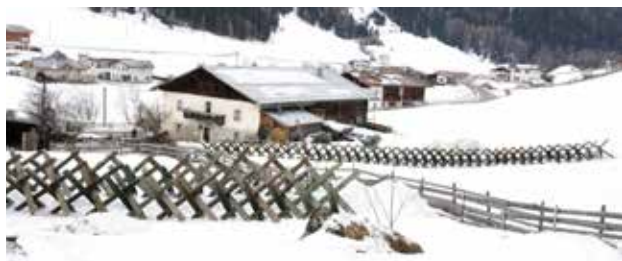
Schutz vor Felsbrocken durch Panzerigel
